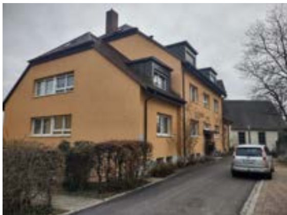
Abbildung 19: Haus 107 Ansicht Nordwest
