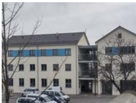
Abbildung 27: Haus 111 Ansicht Nord
