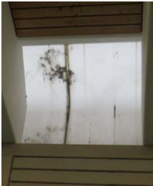
Abbildung 39: Sporthalle Oberlicht Innenansicht
