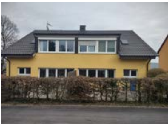
Abbildung 15: Haus 106 Ansicht West
