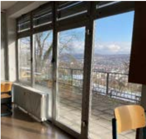
Abbildung 24: Haus 107 Fenster UG innen
