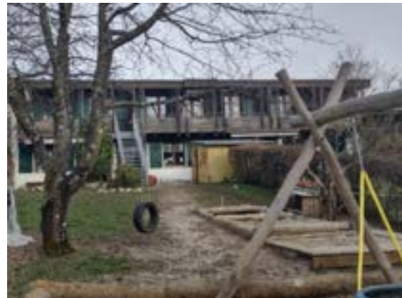
Abbildung 45: Haus 116 Ansicht West
