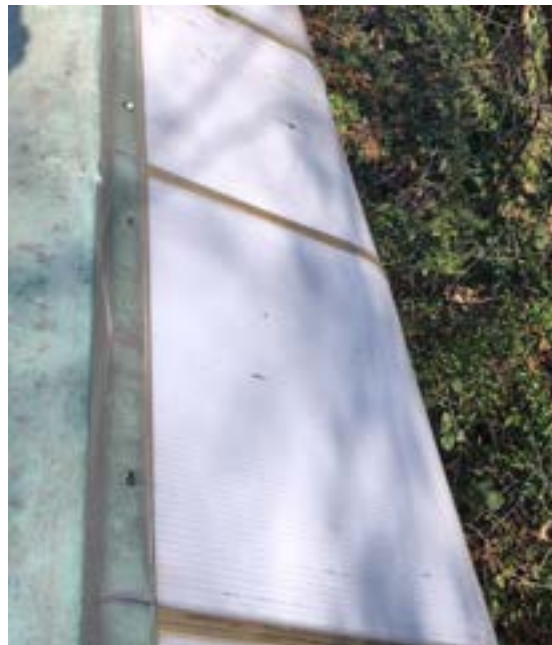
Abbildung 40: Sporthalle Oberlicht Außenansicht
