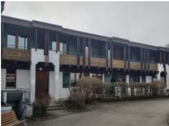
Abbildung 44: Haus 116 Ansicht Nord
