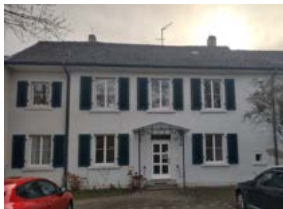
Abbildung 33: Haus 113 Ansicht Nord
