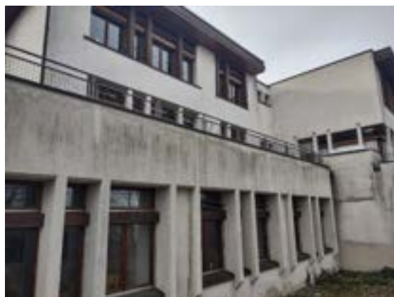
Abbildung 37: Haus 114 Ansicht Südost
