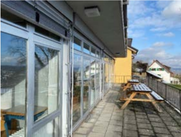
Abbildung 23: Haus 107 Fensterfront UG außen
