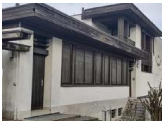
Abbildung 36: Haus 114 Ansicht Nord
