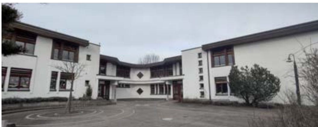
Abbildung 46: Haus 119 Ansicht West
